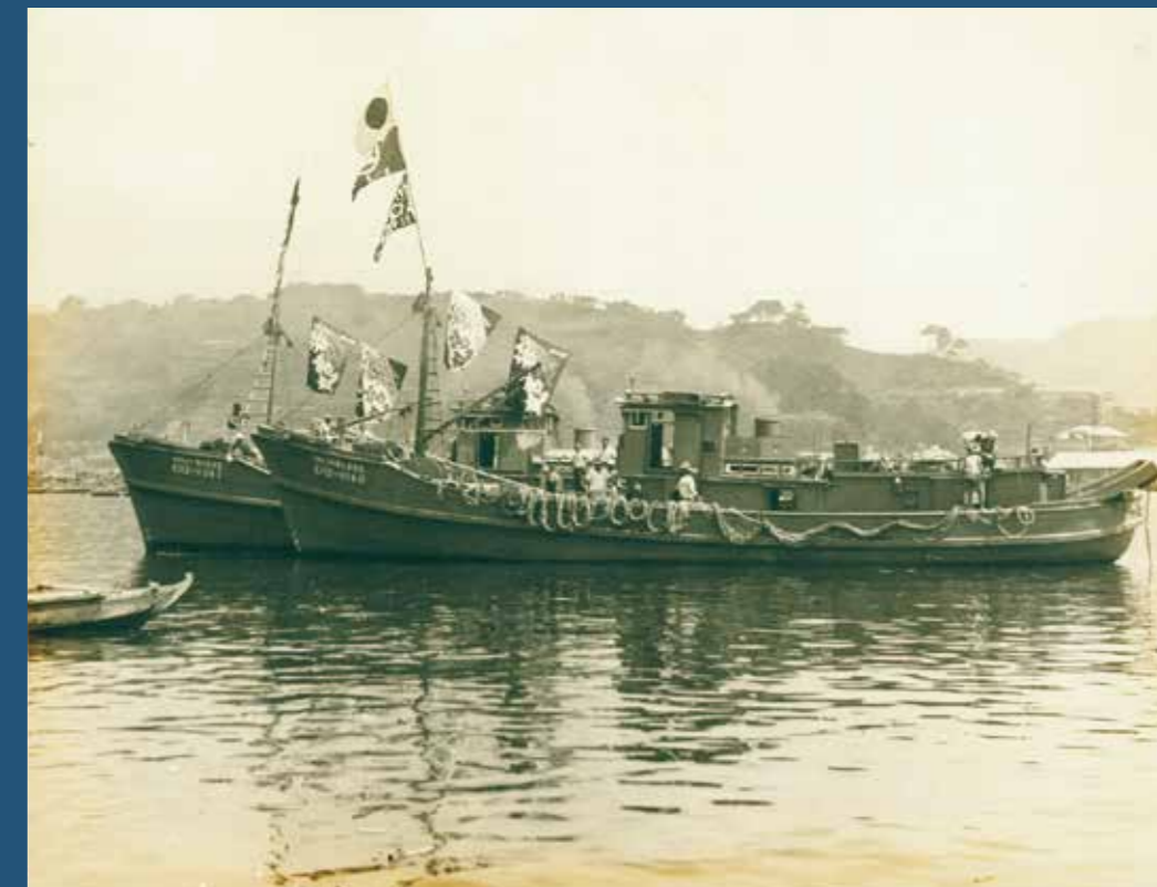
昭和25年頃のトロール船「第7・第8若宮丸」(各32.2トン/135馬力)
